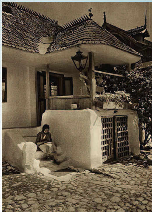
Haus mit Vordach in Breaza.
